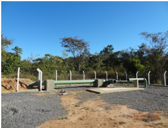
Foto 3 - Construção de uma base para instalação do grupo gerador junto ao Rio Capivari (obra concluída).
