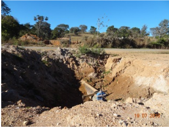
Foto 1 - Construção de adutora do Rio Capivari até a EEAB do Rio Piancó II (obra concluída).
