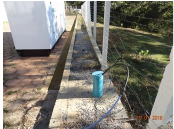
Foto 4 - Poço da área da EEAB do Rio Piancó II a ser interligado ao SAA.
