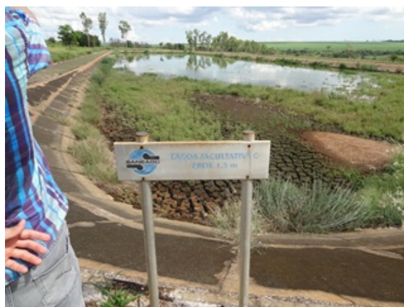
Foto 2 - Lagoas facultativas com infiltração
