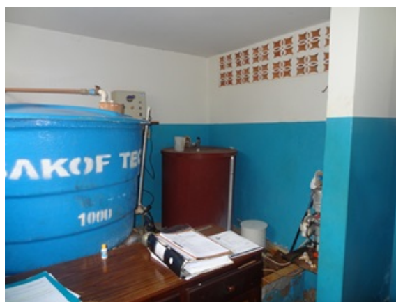
Foto 2 - Uso improvisado das edificações da ETA como escritório comercial do distrito.
