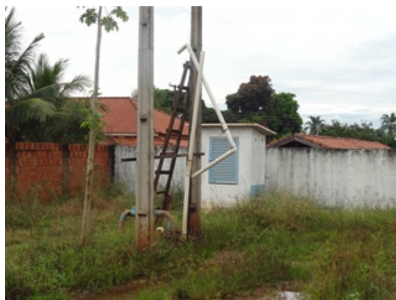
Foto 6 - Poço sem identificação
