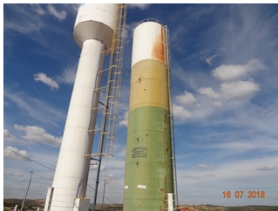
Foto 2 - R.E.L setor Santa Luzia metálico 50 m 3 .
