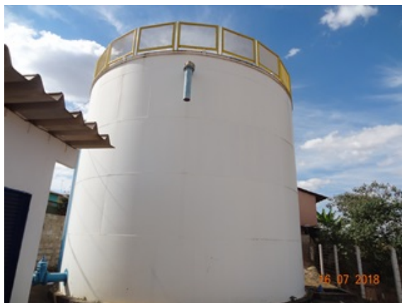
Foto 1 - C.R. Santa Luzia R.A.P metálico 200 m 3 .
