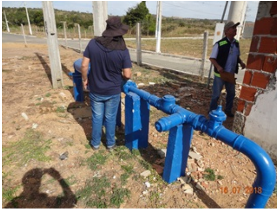
Foto 5 - Poço 14 urbanizado bairro Santa Luzia.
