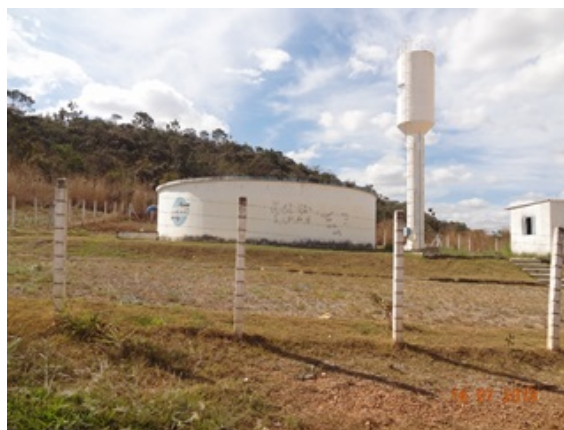
Foto 10 - C.R. Setor Lunabel com reservatórios instalados.
