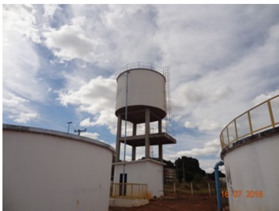
Foto 9 - C.R. Boa Vista com reservatórios instalados.
