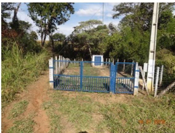
Foto 15 - Poço P 05 interligado à caixa de reunião.
