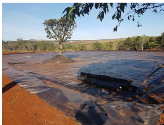
Foto 2 - Instalação de GEOBAG.
