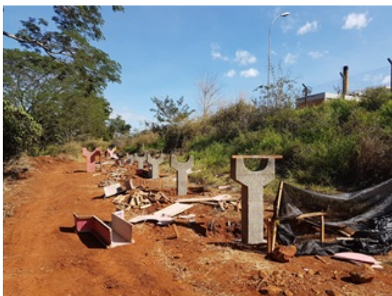
Foto 3 - Trecho aéreo do Interceptor Queixada.
