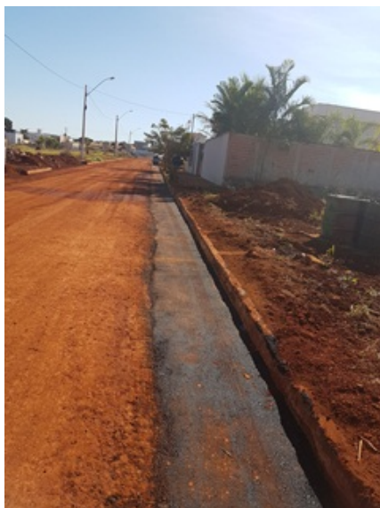
Foto 5 - Rede coletora no Bairro Brisas I.
