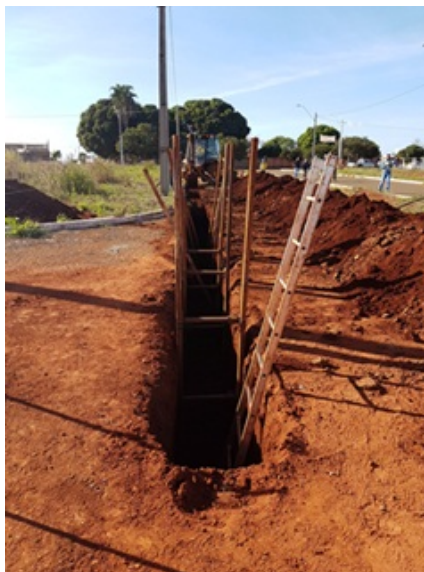
Foto 4 - Rede coletora no Bairro Brisas I.
