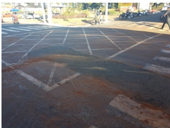
Foto 1 - Substituição rede de distribuição - Centro - entre Av. Goiás e a Rua Rui Barbosa.
