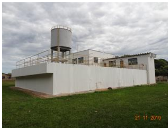
Foto 2 - ETA com edificações recuperadas.
