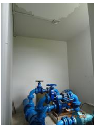
Foto 3 - EEAT da ETA com pintura e revestimento recuperado.
