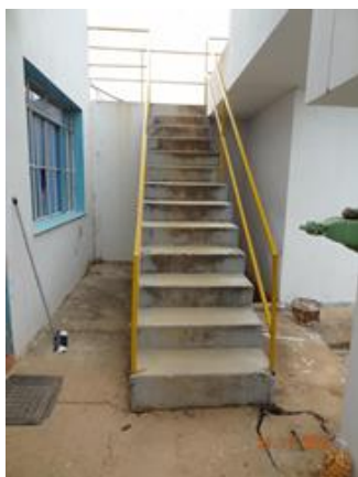
Foto 1 - Corrimão da escada de acesso aos floculadores recuperada.
