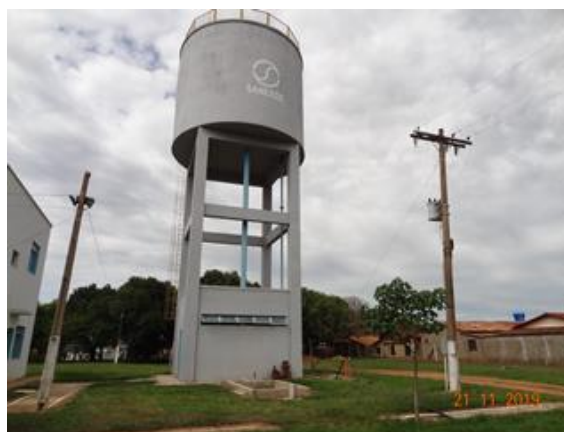
Foto 4 - REL da ETA com pintura recuperada.
