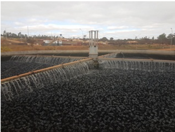
Foto 1 - Filtro Biológico, com material randômico - ETE Santo Antônio
