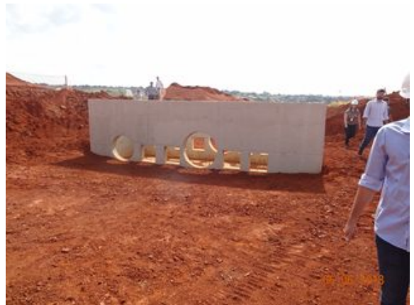
Foto 4 - Montagem de Sifão
