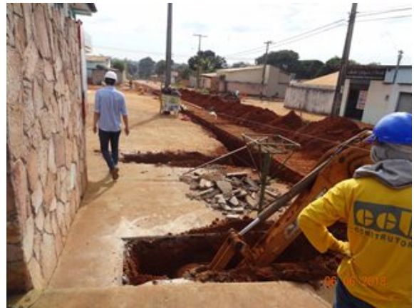
Foto 2 - Construção de rede coletora de esgoto - Papillon Park
