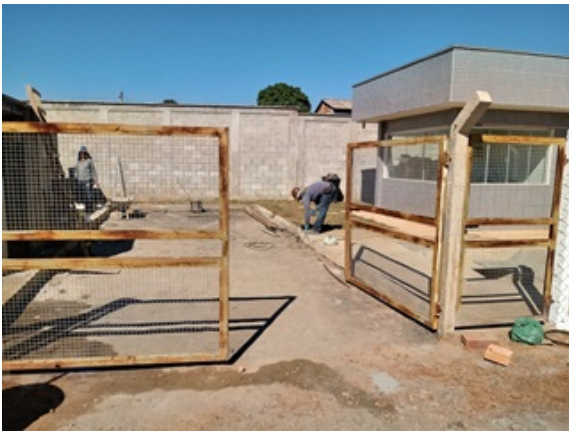
Foto 5 - Finalização da Caixa de Reunião - Alto Paraíso
