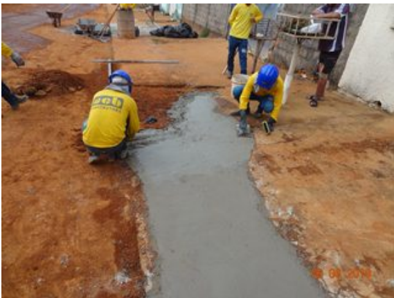
Foto 3 - Restauração de calçadas e ruas, pós construção de rede coletora - Papillon Park
