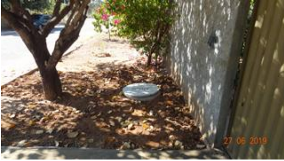
Foto 3 - Poço Visita relocado recentemente na parte externa de residência no trecho da Rua A.
