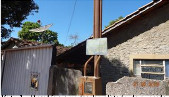
Foto 1 - Residência no trecho afetado da avenida A.
