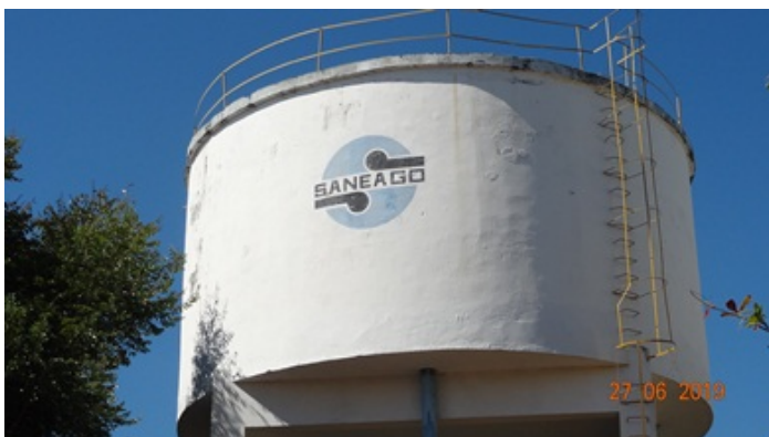
Foto 1 - REL da ETA com infiltração recuperada
