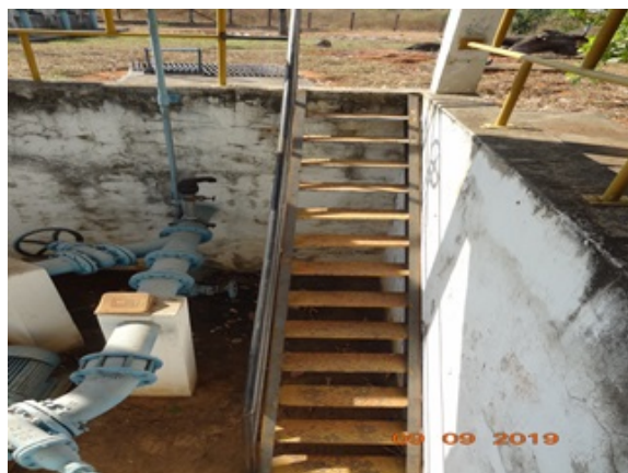
Foto 1 - Escada de acesso à EEAT com guarda-corpos.
