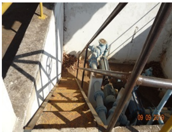
Foto 2 - Escada de acesso à EEAT com guarda-corpos.
