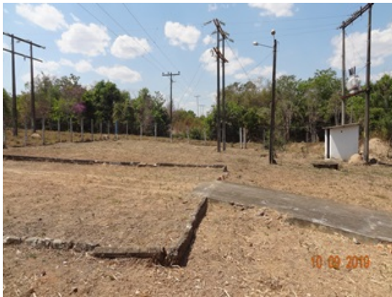
Foto 3 - Área da captação/EEAB com constatação solucionada (limpeza da área).
