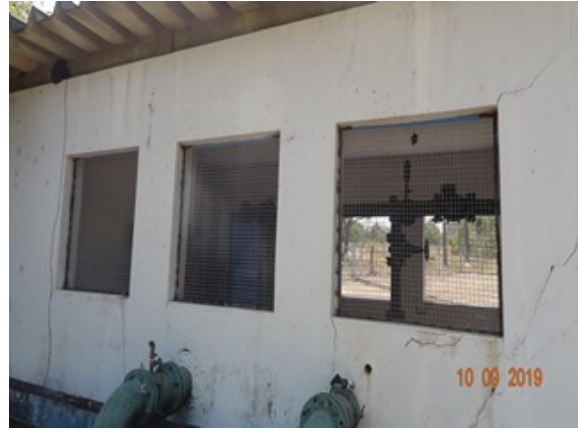
Foto 2 - EEAB/captação com janelas recuperadas.
