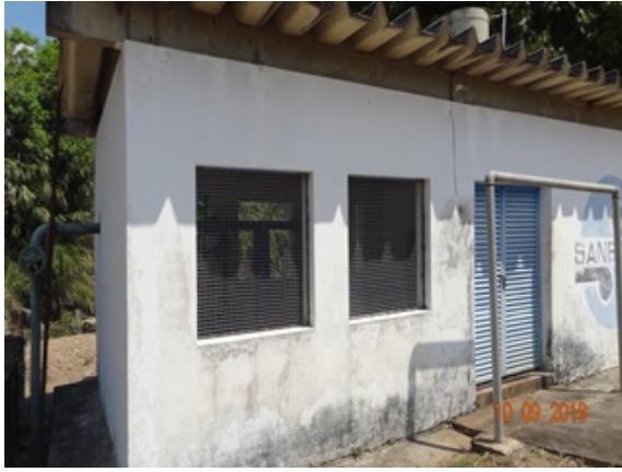
Foto 1 - EEAB/captação com janelas recuperadas.
