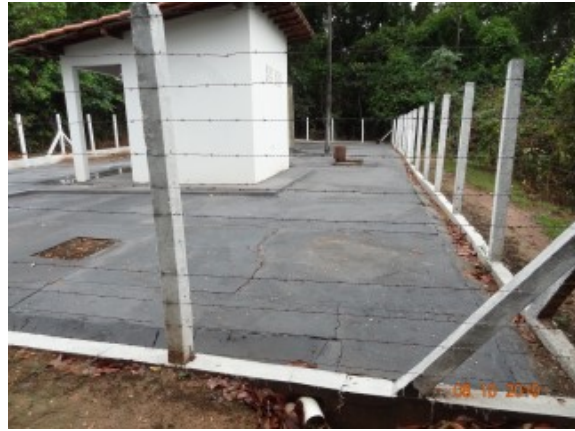
Foto 4 - Vista da pintura das edificações da EEE II/Buqueirão.
