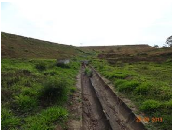
Foto 1 - ETE com boas condições de acessibilidade ao ponto de lançamento do efluente no corpo receptor.
