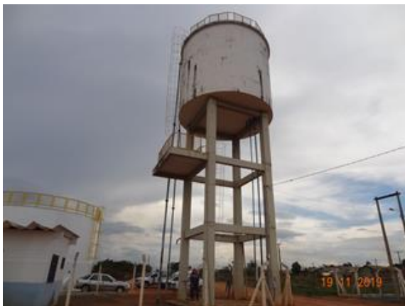
Foto 1 - REL Parque da Colina com guarda-corpo no topo do reservatório.
