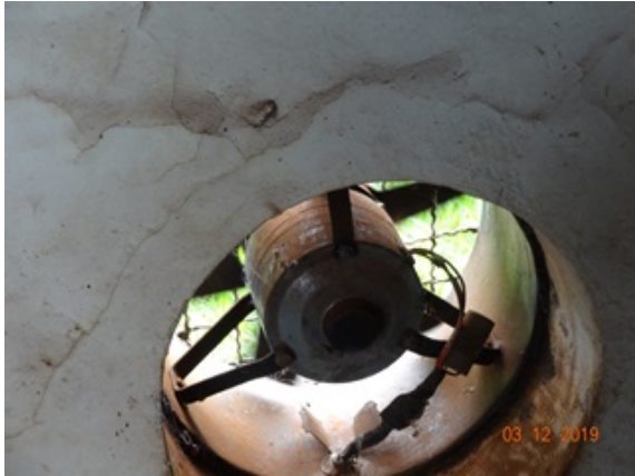
Foto 1 - ETA com exaustor da sala de cloração recuperado.
