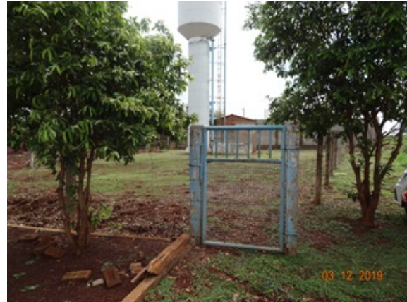
Foto 2 - REL Nossa Senhora da Guia com cerca de proteção recuperada.
