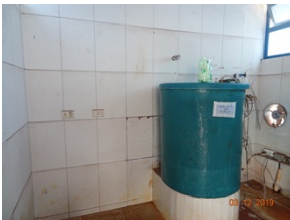
Foto 5 - ETA/casa de química. Parte interna revestida.
