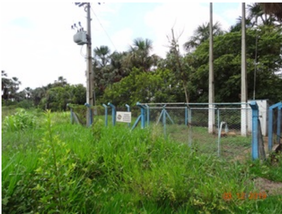
Foto 3 - Poço 07 (Novo) com edificações recuperadas.
