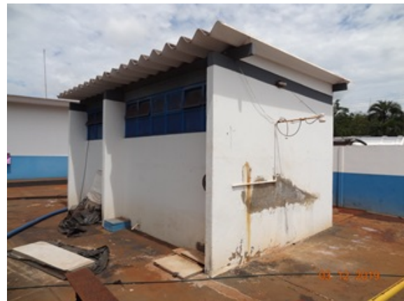
Foto 4 - ETA/casa de química. Parte externa com edificações recuperadas.
