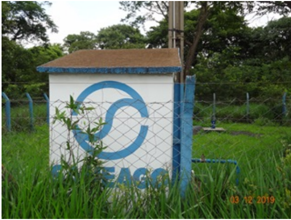
Foto 1 - Poço 02 (Lagoa) com edificações recuperadas.
