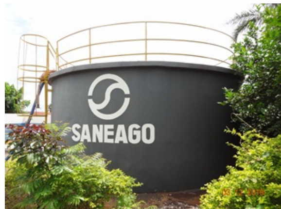
Foto 6 - ETA/RAP com pintura recuperada.
