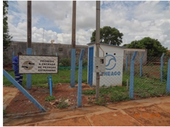
Foto 2 - Poço 03 (Laticínio) com edificações recuperadas.
