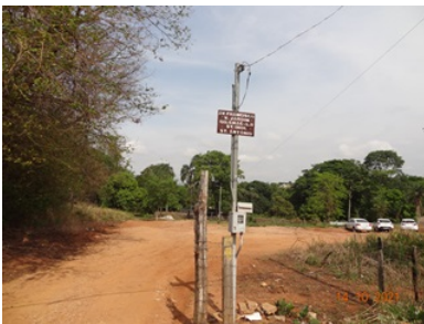
Foto 1 - Placa de endereço da obra
