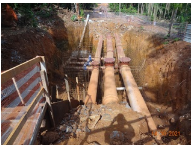
Foto 3 - Obras no sifão Terra Prometida
