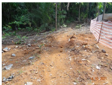
Foto 6 - Obras no sifão Terra Prometida
