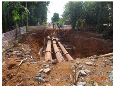
Foto 2 - Obras no sifão Terra Prometida
