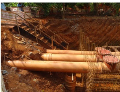
Foto 5 - Obras no sifão Terra Prometida
