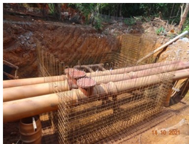
Foto 4 - Obras no sifão Terra Prometida
