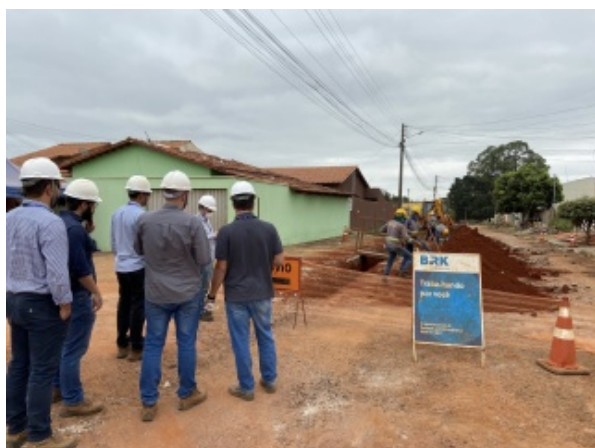
Foto 3 - Fiscalização das obras.
