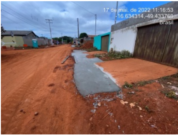
Foto 11 - Recomposição de calçada sendo executada.
