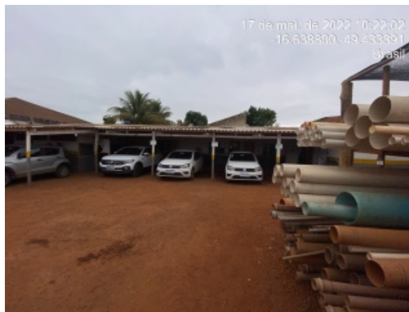
Foto 2 - Canteiro de obras da CCB Construtora.
