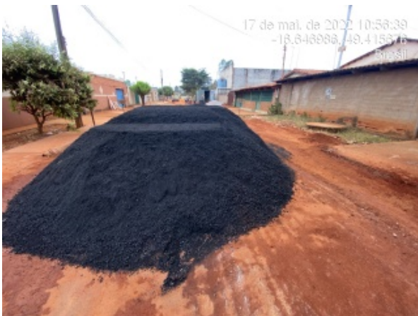
Foto 9 - CBUQ utilizado na recomposição de vias pavimentadas.
