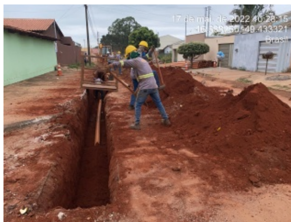
Foto 4 - Equipe de escavação em serviço.
