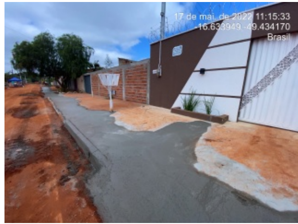
Foto 12 - Recomposição de calçada finalizada.
