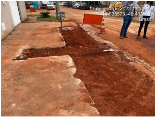
Foto 5 - Trabalho da equipe de escavação finalizado na calçada.
