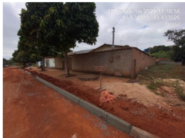
Foto 10 - Recomposição de guia da calçada sendo executada.
