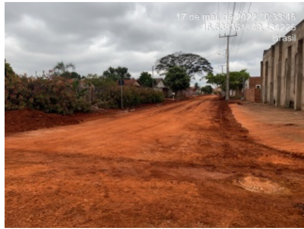
Foto 6 - Trabalho da equipe de escavação finalizado na rua.
