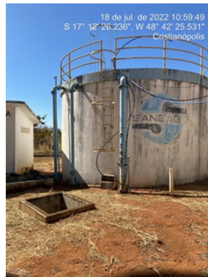
Foto 2 - RAP com guarda corpo instalado.
