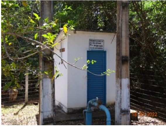
Foto 5 - Poço 06 agora renomeado PGB 145, com identificação fixada.
