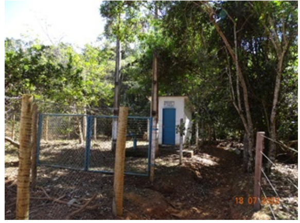
Foto 6 - Poço 06 agora renomeado PGB 145, com edificações pintadas.
