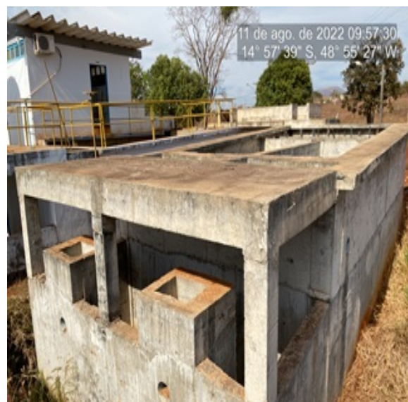
Foto 4 -Edificação da construção da nova ETA de Barro Alto.
