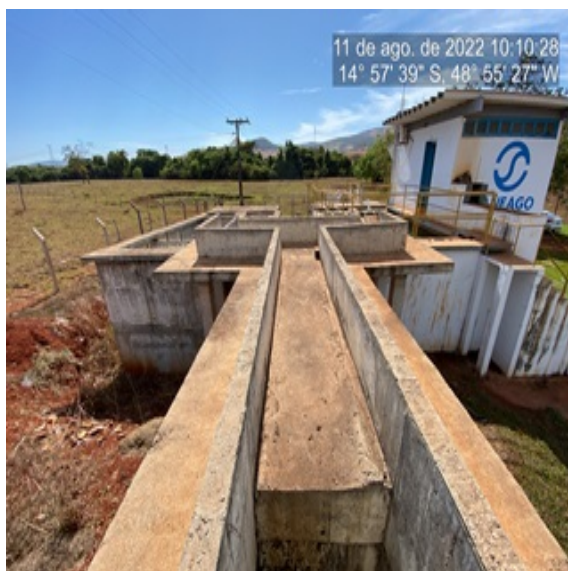
Foto 3 - Edificação da construção da nova ETA de Barro Alto.
