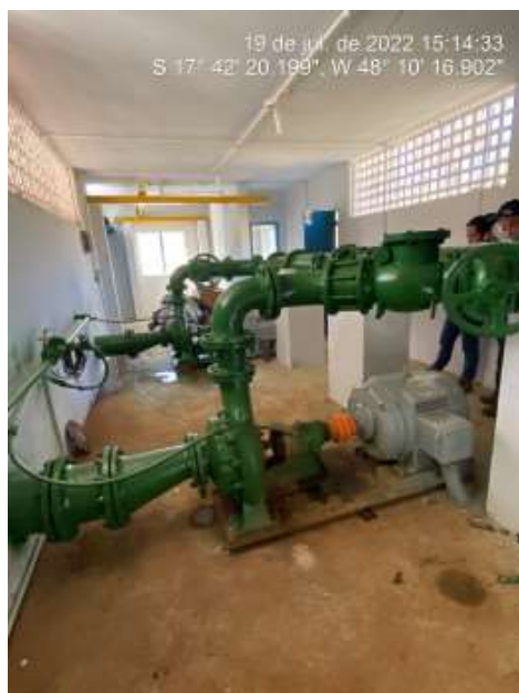
Foto 1 - EEAB com ausência de vazamento.
