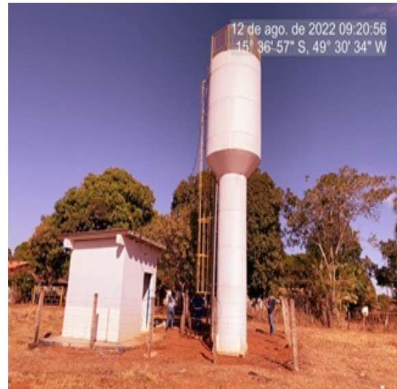
Foto 4 - Vista da área ETA com cerca de segurança renovada.
