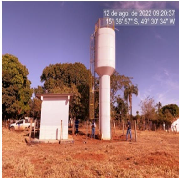
Foto 3 - Vista da área da ETA com REL novo instalado.
