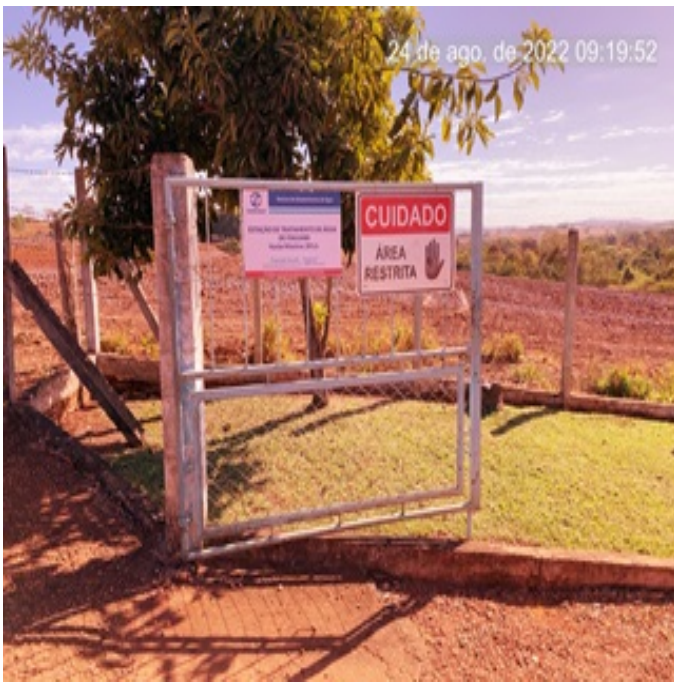
Foto 1 - ETA com placa de aviso de risco instaladas em todas áreas urbanizadas.
