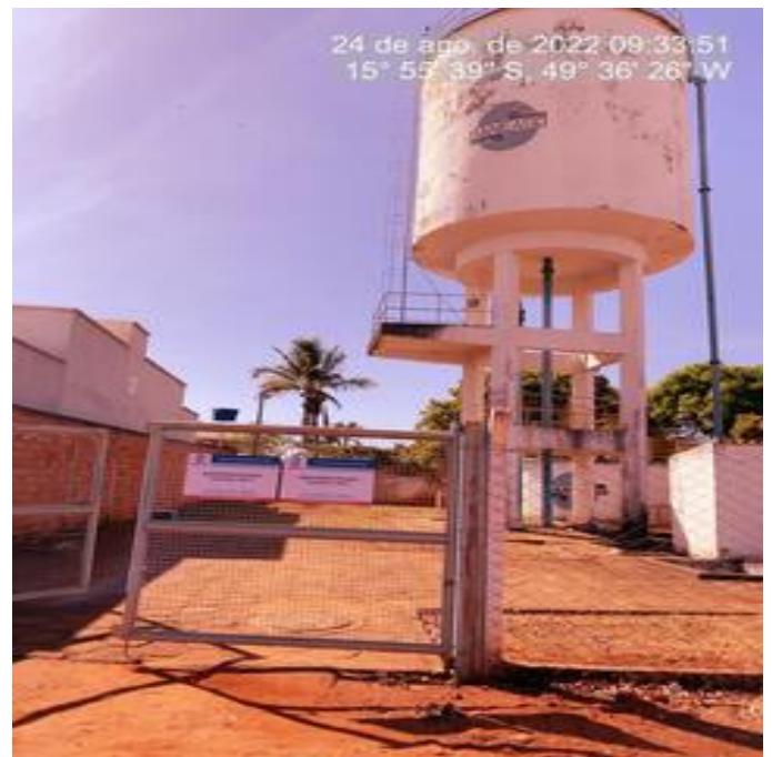
Foto 4 - Centro de Reservação com portão
