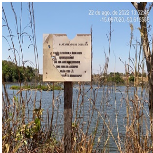
Foto 7 - EEAB/Captação com placa de identificação danificada.
