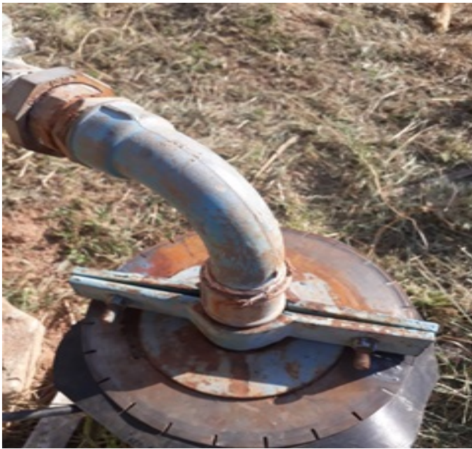
Foto 7 - Poço 04 - Papyrus com a boca do poço corrigida.
