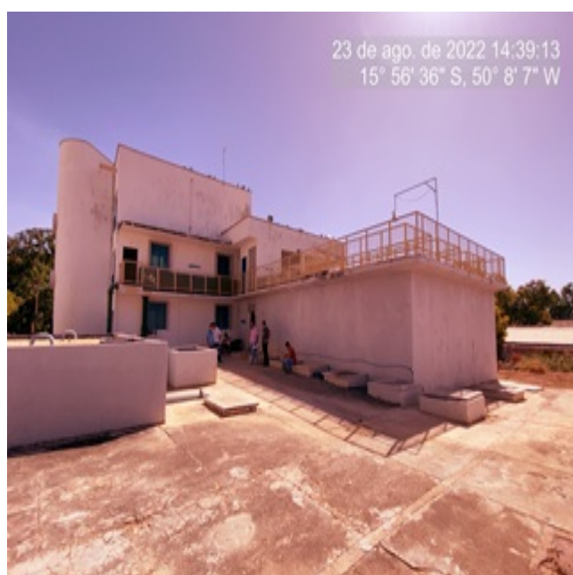
Foto 1 - ETA Bacalhau com pintura recuperada.
