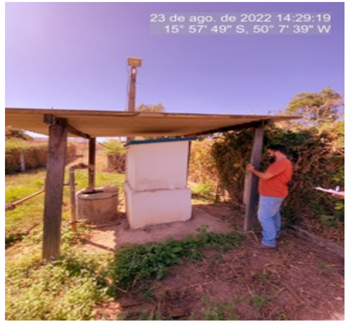
Foto 8 - Poço 04 - Papyrus com abrigo do quadro de comando recuperado.
