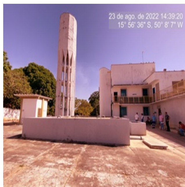
Foto 2 - ETA Bacalhau com pintura recuperada.
