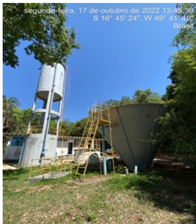
Foto 1 - ETA com edificações recuperadas.
