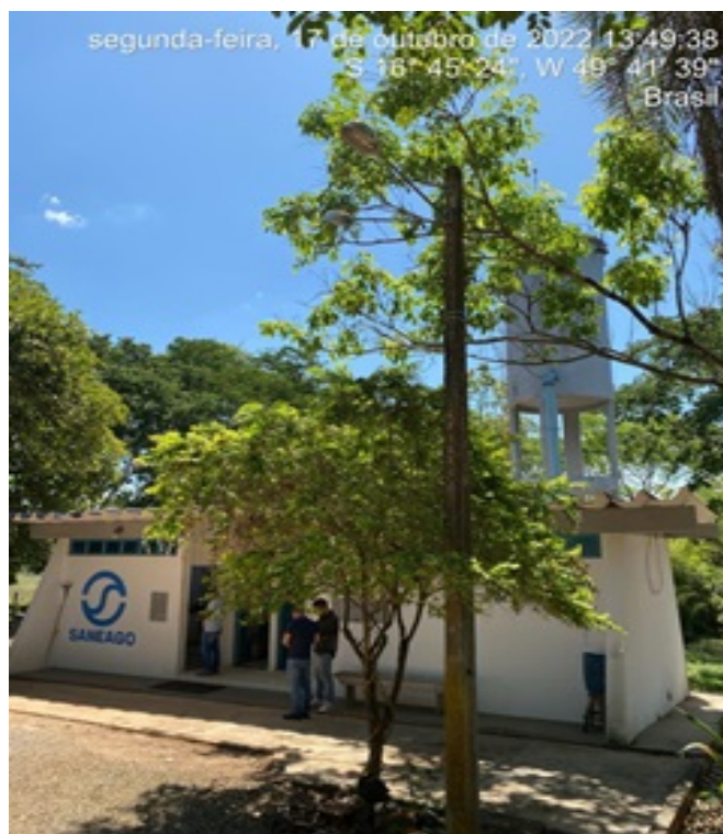
Foto 2 - ETA com edificações recuperadas.
