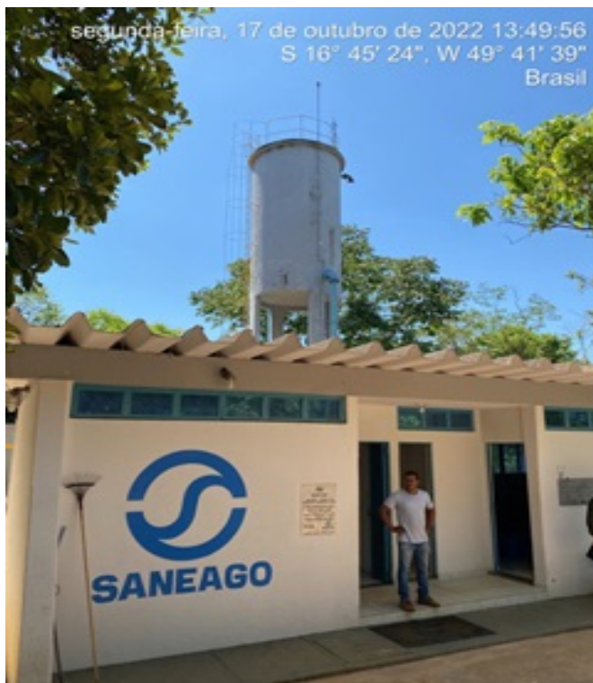
Foto 3 - ETA com edificações recuperadas.
