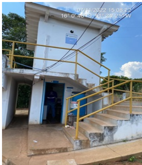
Foto 4 - ETA II com guarda corpos/corre-mão instalados.
