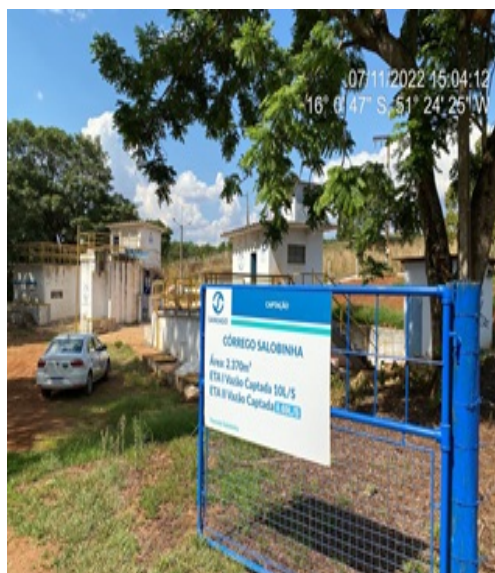
Foto 6 - ETA I e II com pintura recuperada.
