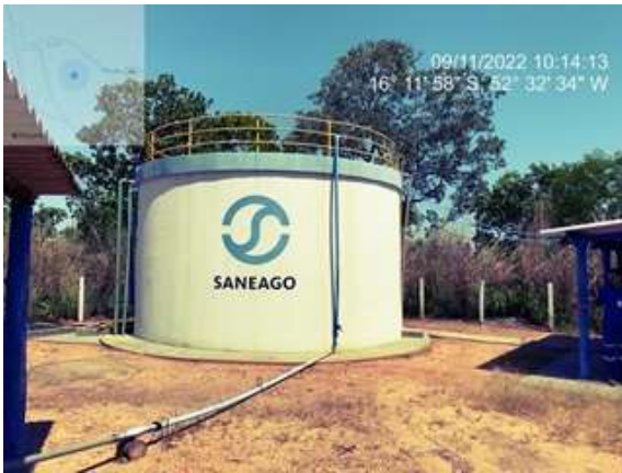
Foto 3 - RAP com pintura recuperada.
