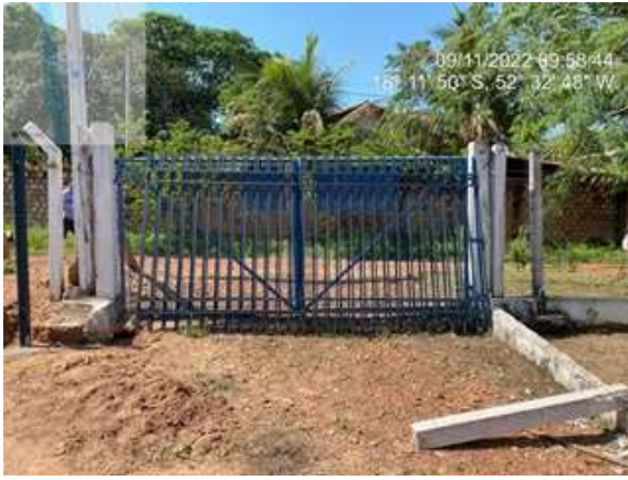
Foto 1 - Escritório comercial com cerca e portão recuperados.
