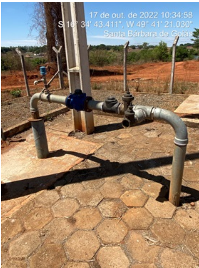
Foto 1 - Poço P 04 com vazamento corrigido (Faz. Santa Bárbara).
