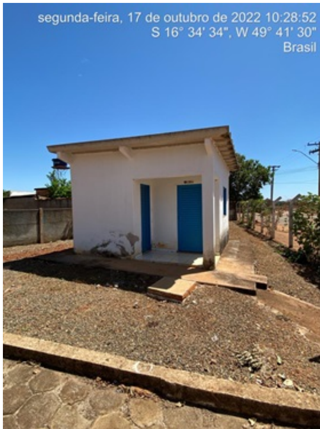
Foto 7 - REL do setor Assis Silva com casa de química recuperada.
