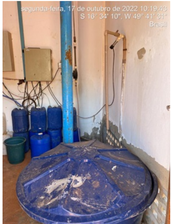
Foto 6 - REL do Distrito casa de química com pintura recuperada.
