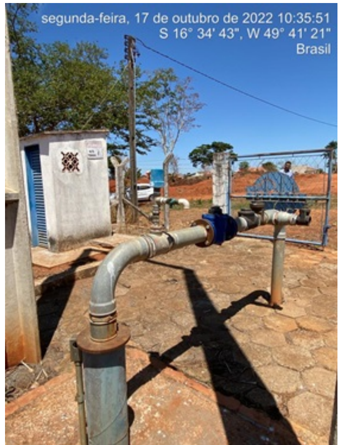
Foto 2 - Poço P 04 com vazamento corrigido (Faz. Santa Bárbara).
