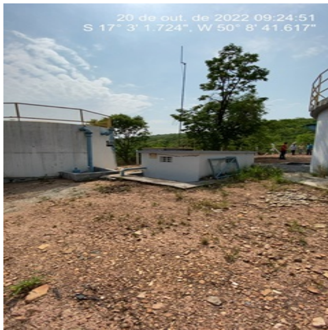
Foto 2 - C.R. da zona rural com a pintura das edificações recuperadas.
