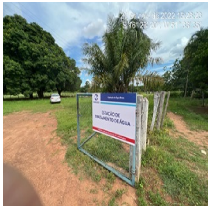
Foto 2 - ETA com placa de identificação instalada.
