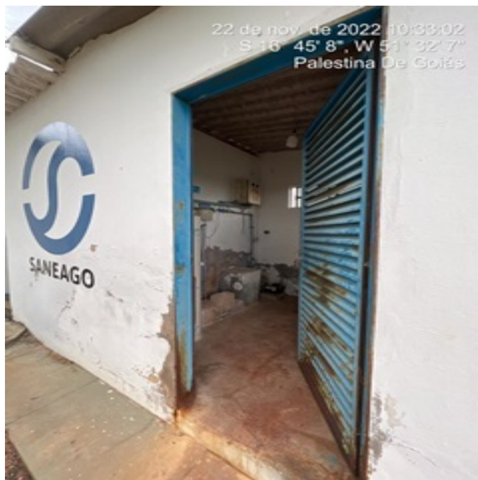
Foto 6 - Casa de química/Serrinha com pintura e revestimento recuperado.
