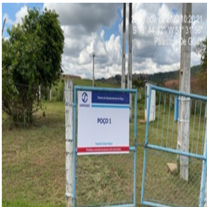
Foto 3 - Poço 01 com placa de identificação recuperada e instalada.
