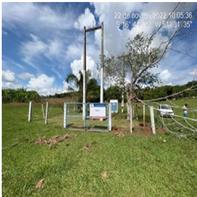
Foto 1 - Poço 02 com placa de identificação recuperada e instalada.
