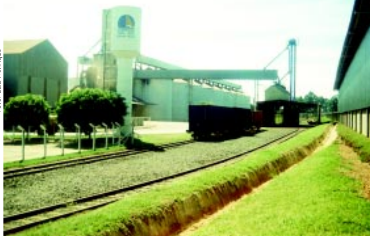
Porto Seco Centro-Oeste
