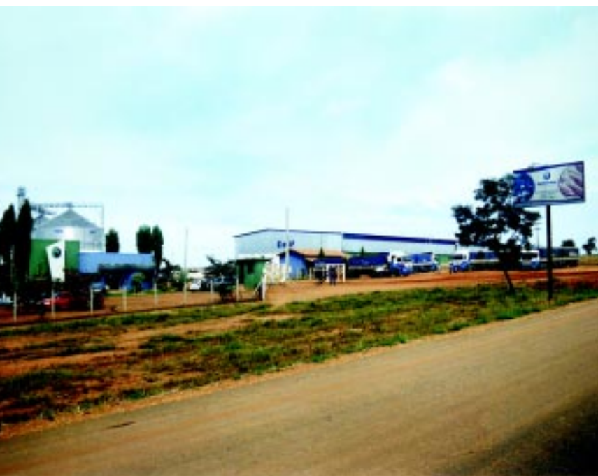
Califórnia Algodoeira e Armazéns Gerais
