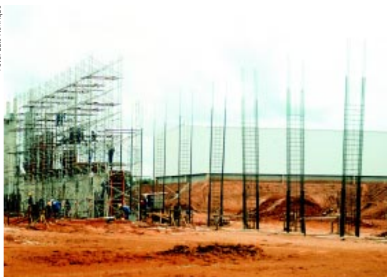
Construção da Jaepel Papéis e Embalagens
