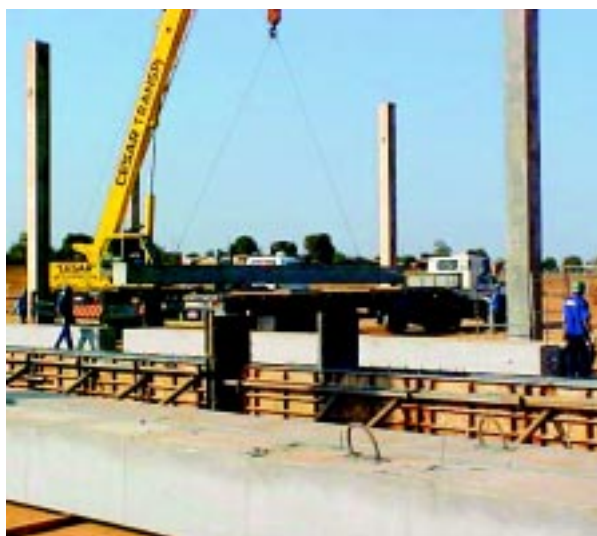
Obras da fábrica da Hyundai em Anápolis
